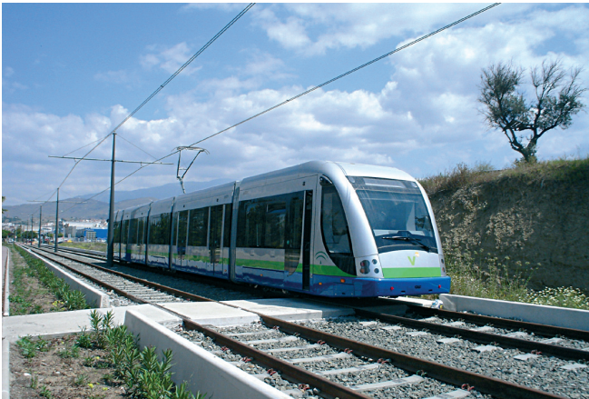
Figure 13 – Tramway espagnol Vélez-Málaga (photo JM Valero)
