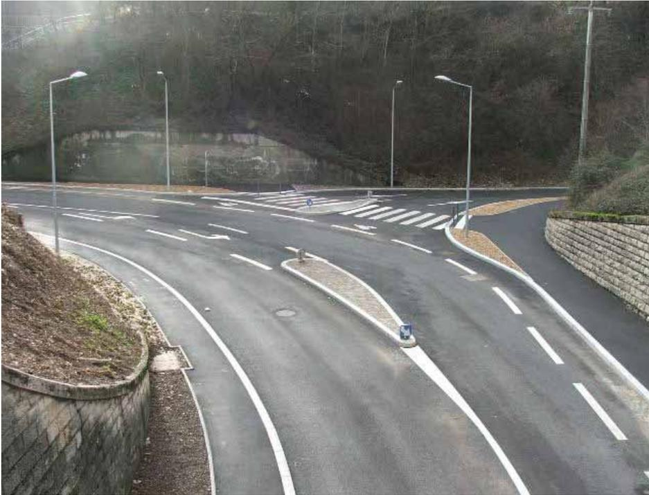
En contrebas de la gare SNCF, l'accès à l'ancien parking a été réaménagé pour le rendre plus sécuritaire : réfection complète de la chaussée, mise en place d'un îlot pour protéger les mouvements tournants entrant dans le parc relais depuis le haut, sécurisation des piétons avec traversée munie d'un îlot...
