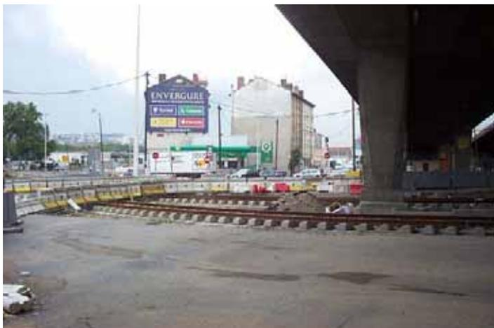
Les voies de T1 lors des travaux de finalisation de la plateforme sous l'autopont de l'A7 à la hauteur du Pont Pasteur.
