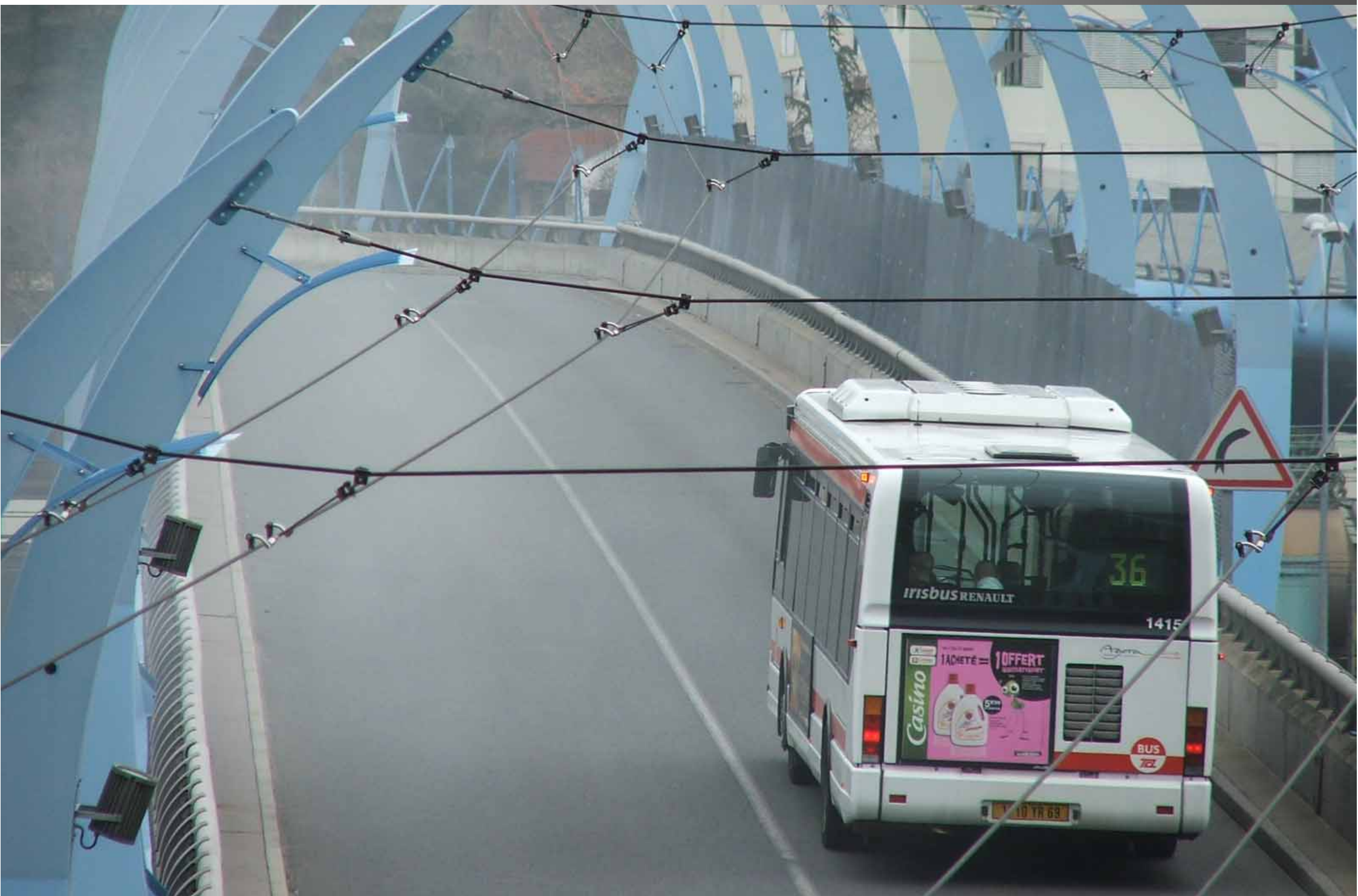
La ligne 36 sous les lignes aériennes fantômes de la ligne 44 - Viaduc de la Duchère, Lyon 9
