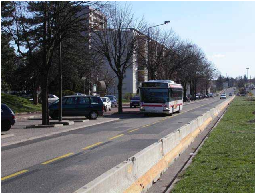
Balisage du chantier T4 sur le Bd A. Croizat – Photo Manu69
