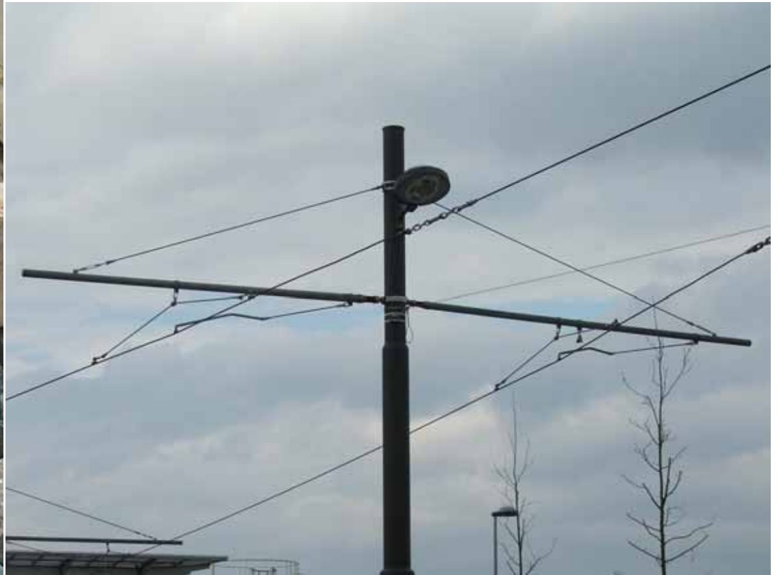
Dans le dépôt, les lignes aériennes sont déjà tendues
