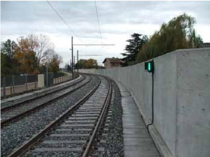
*Signal ferroviaire indiquant la présence d'un aiguillage permettant la communication entre les 2 voies de circulation. La signal au vert vertical signifie que le passage est libre et que l'aiguille est en position dite « directe ». Le signal diagonal jaune signifie que le passage est autorisé à vitesse réduite pour une aiguille dite en position « déviée ». Le signal rouge horizontal annonce un arrêt obligatoire.*
