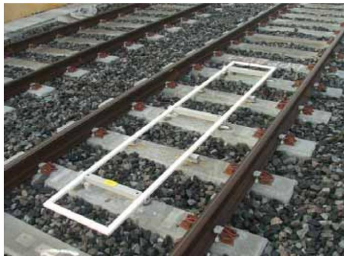
*Ci-dessus, une boucle de détection pour la gestion des intersections barrières et pour les carrefours à feux tricolores.*
