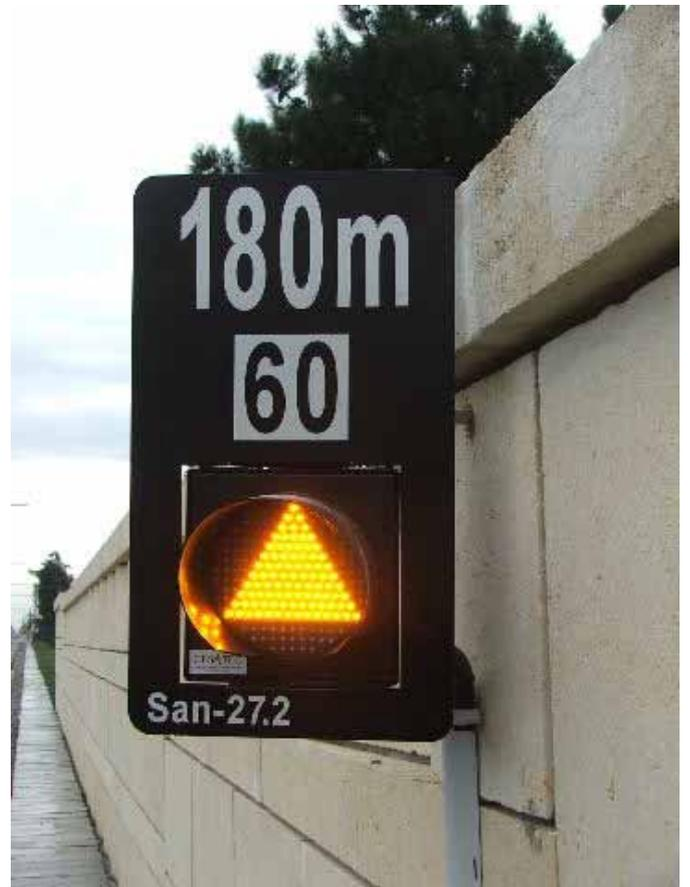
*Vue en gros plan d'un signal d'IB (Intersection Barrière) avec la présence d'un tableau indicateur de vitesses.*
