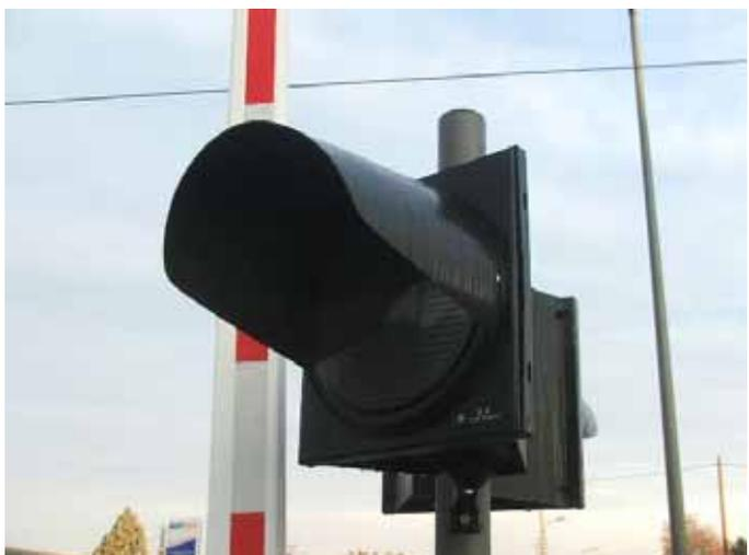
*Signal R24 pour les véhicules, accompagné de sa barrière : hormis sa forme, son fonctionnement est identique aux signaux rencontrés aux abords des passages à niveau du réseau ferroviaire national.*
