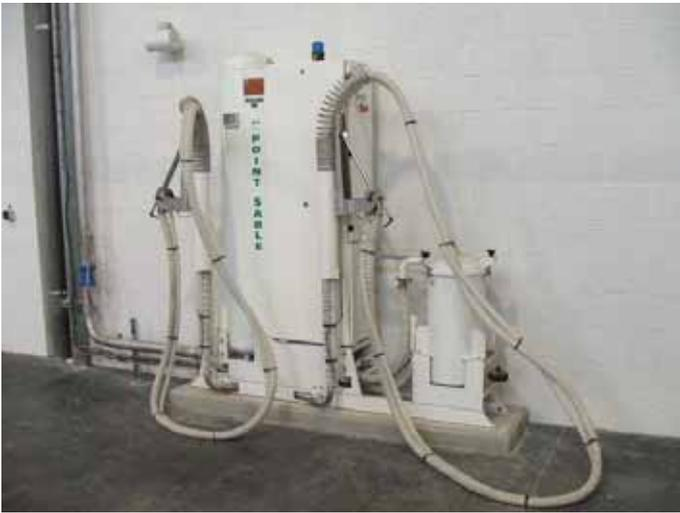
Installation destinée à faire le plein de sable de la rame. Le sable sert à augmenter l'adhérence des rames notamment en cas de pluie. Il est injecté devant les roues de la rame.
