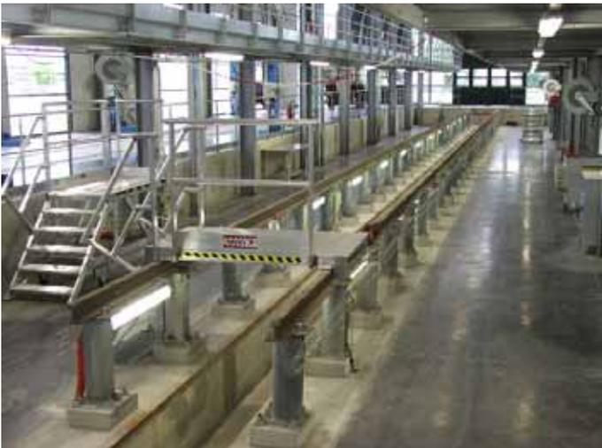
*Dans le entre de maintenance, les voies sont surélevées sur pilotis pour permettre l'inspection du dessous des rames si besoin.*
