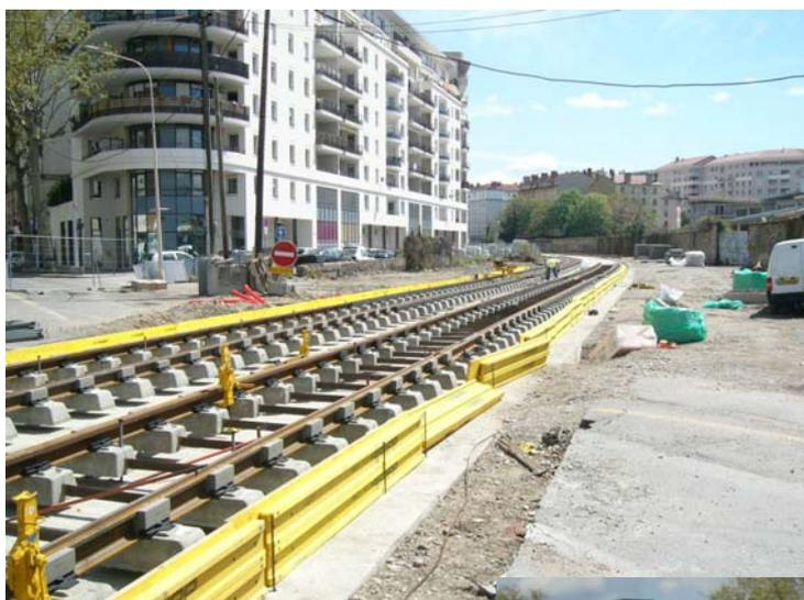
Les rails sont posés, la planéité et l'écartement sont soigneusement contrôlés par les techniciens d'Alstom
