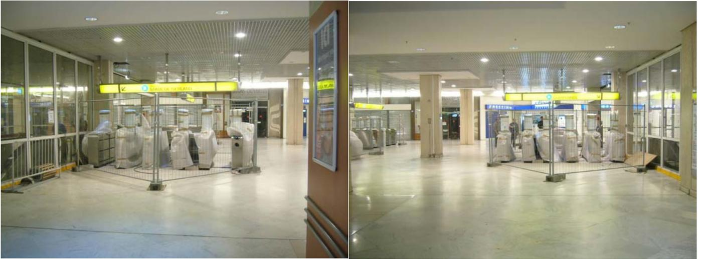
A la Part Dieu, la présence d'une mezzanine côté centre commercial facilite grandement l'implantation des portillons de contrôle d'accès. Ils peuvent en effet être tous alignés pour créer une vaste zone où les voyageurs pourront choisir leur destination après le franchissement de la zone de péage.
