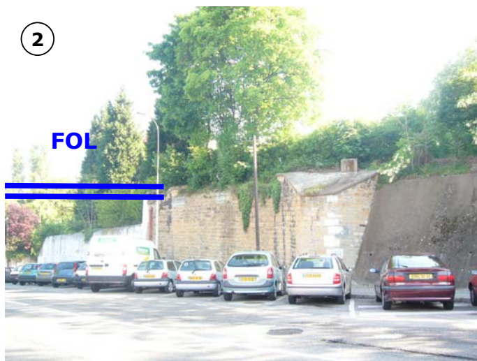
Emplacement de l'ancien pont au-dessus de la rue Audry
