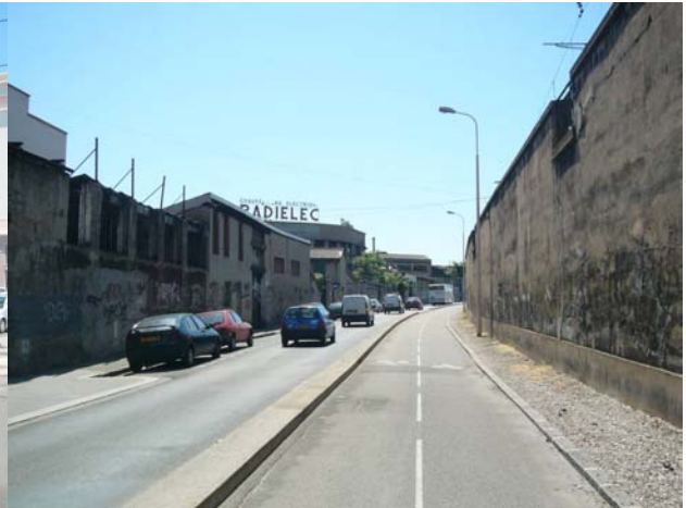
La rue du Vivier, autrefois autoroute à 2 voies, a été reconverte en piste cyclable.
