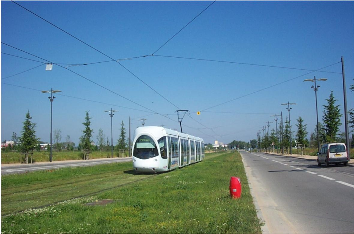
Ici, à proximité du Parc Technologique sur la ligne T2, les poteaux de LAC sont placés loin de chaque côté des rails, et des câbles sont tendus de part et d'autre de la voirie.
