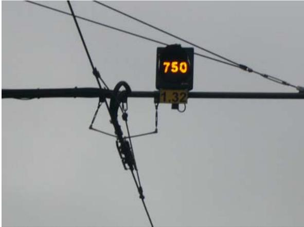
Pour connaître l'état de la ligne, les conducteurs disposent d'un indicateur situé au-dessus de chaque sectionnement : il indique « 750 » lorsque la ligne est alimentée normalement. Ce 750 clignote lorsque la ligne n'est pas alimentée.
