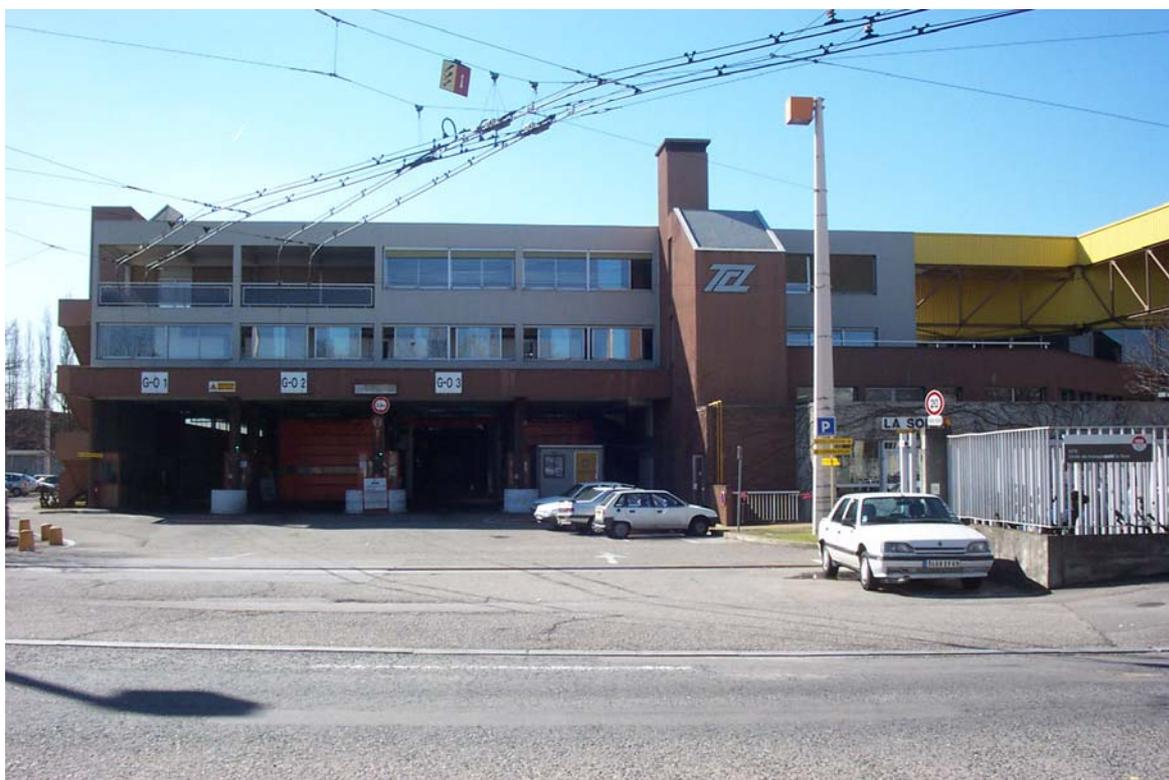
Ici au dépôt de la Soie, les lignes aériennes qui relient Laurent Bonnevey au dépôt. Les lignes s'arrêtent aux pompes à gazoil à l'entrée du dépôt. À l'intérieur de l'unité de transport, les bus circulent en autonomie. À la sortie, les trolleybus peuvent à nouveau emprunter une ligne de service qui les ramène à Laurent Bonnevey.
