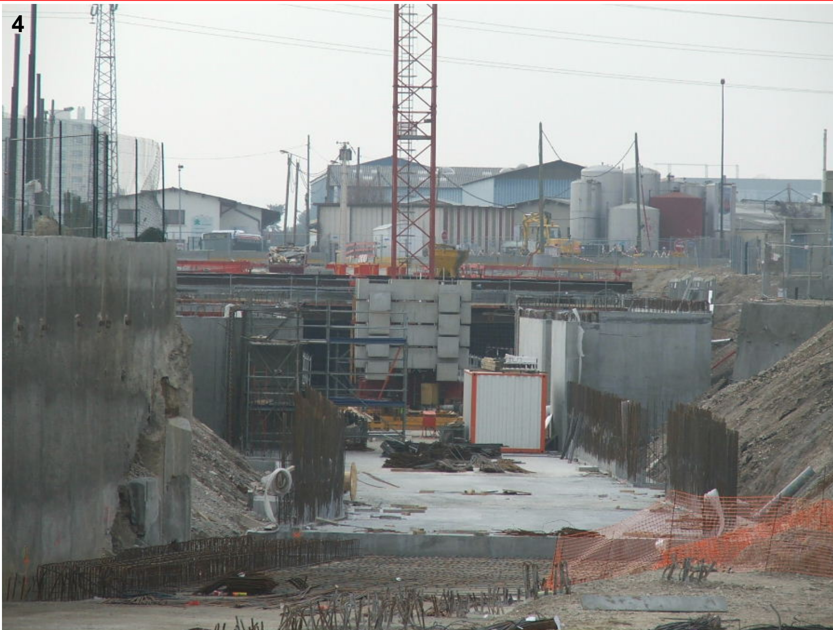
La station, vue depuis le tiroir de retournement en construction
