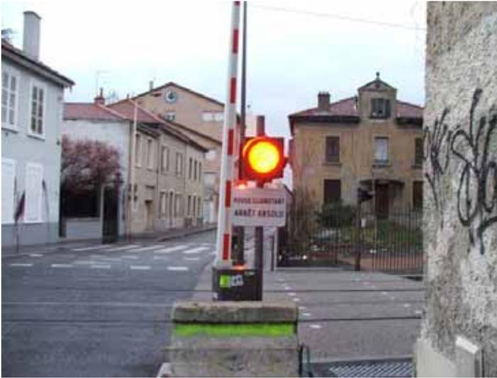
Dans les carrefours à feux ou dans les passages à niveau, l'approche d'une rame est signalée par l'allumage alterné d'un signal rouge. Ce signal s'adresse aussi bien aux véhicules qu'aux piétons. Parfois, des signaux supplémentaires de plus petite taille sont implantés en aval pour les piétons, afin de faciliter leur perception du signal. Ils sont également équipés d'une synthèse vocale pour les personnes aveugles et malvoyantes, qui peuvent les actionner à l'aide d'une télécommande.
