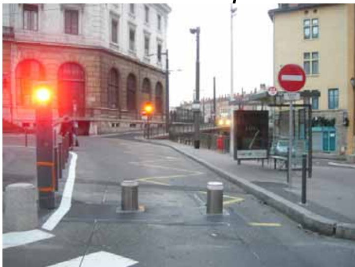
St Paul Gare : un retournement en site propre a été créé derrière la gare SNCF de Lyon St Paul. Il est gardé par un contrôle d'accès à bornes escamotables, qui sont malheureusement hors service depuis de nombreux mois...
