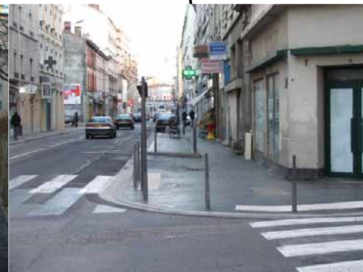
Station Blanqui - Tolstoi : alignement de la bordure sur la voie de circulation, et mise à la norme PMR.
