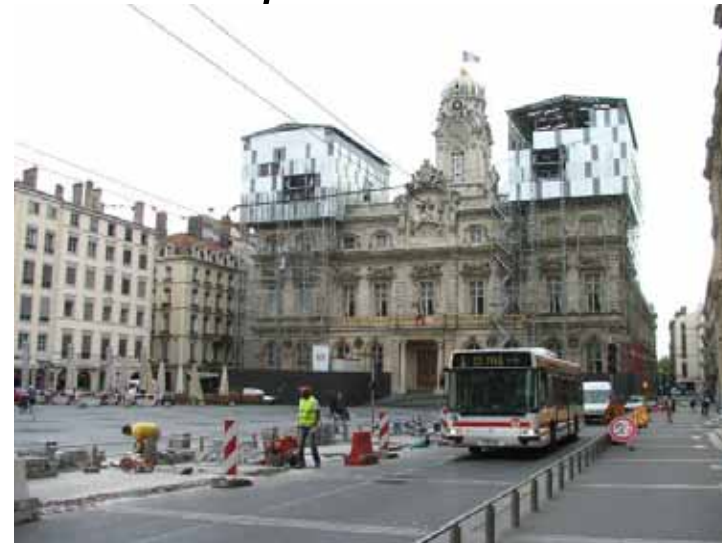
Le long de la place des Terreaux : le couloir bus a été complètement refait, en profondeur, l'été 2006.
