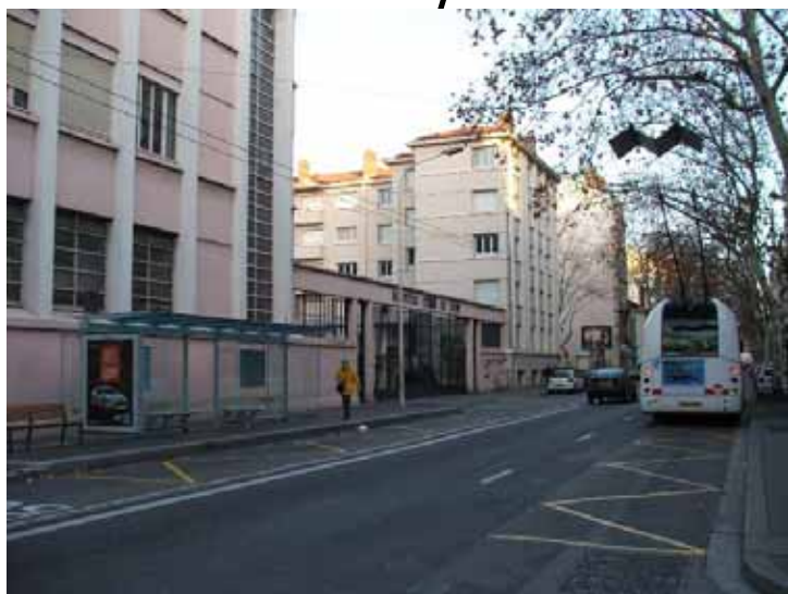
Station Sainte Geneviève : mise en alignement de la bordure sur la voie de circulation, et mise à la norme PMR.
