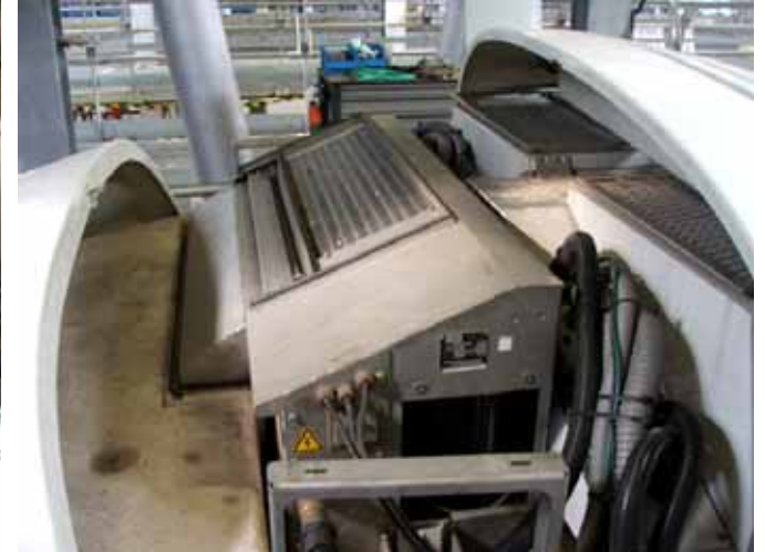
La climatisation conducteur sur le front de la rame.
